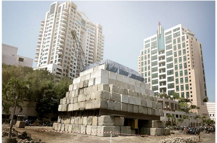
右上: 轴向压缩静载荷试验中使用的配重
